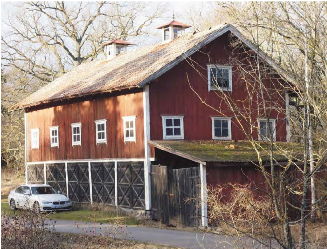
Foto som visar magasinsbyggnaden. Fotografi från kulturmiljöutredningen (Fredriksson Arkitektkontor, 2023)
