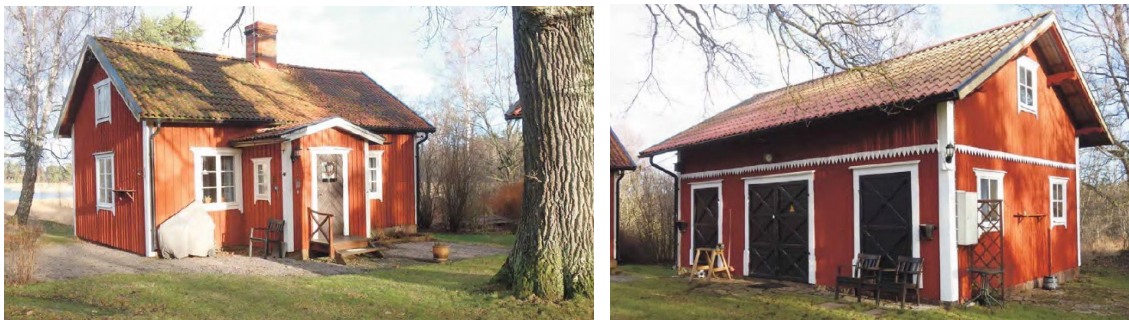
Foton som visar drängstugan och uthuset. Fotografier från kulturmiljöutredningen (Fredriksson Arkitektkontor, 2023)
