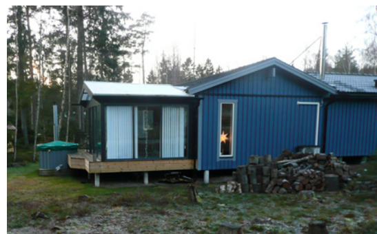
Hus med plintgrund på lerjord nära havet.
